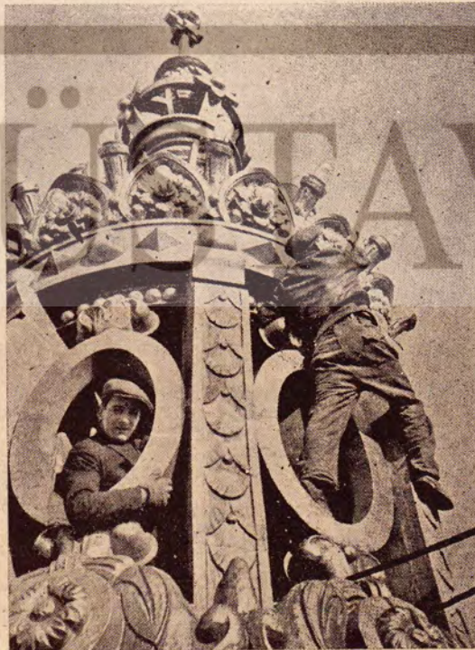
Central Building in tepesinde, baş döndürücü bir irtifada elektrik têsisatı yapılırken.
